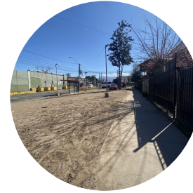
Deterioro del espacio público y vías principales
